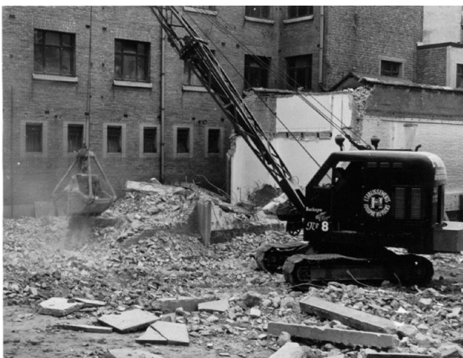
(c) Pelle mécanique sur un chantier de démolition bruxellois, dans les années 1950
