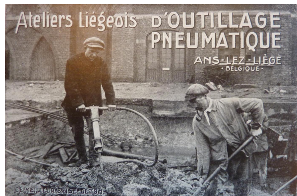
(b) Outillage pneumatique de démolition
