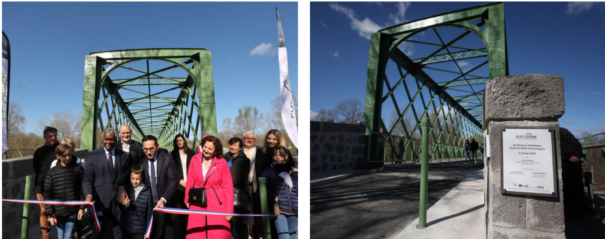
FIG. 5.3 : Inauguration des travaux de rénovation du pont métallique de Dallet (CLERMONTINFOS63.FR 2024)
