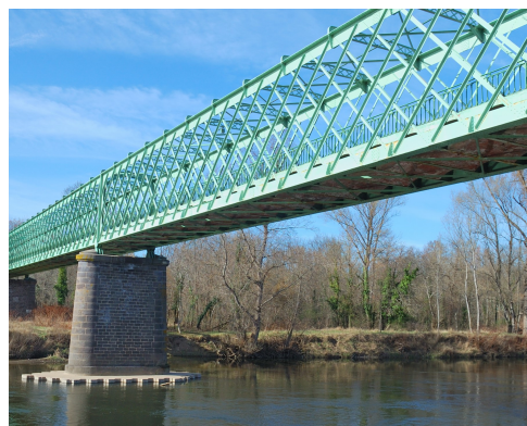
(a) Vue du pont de Dallet
