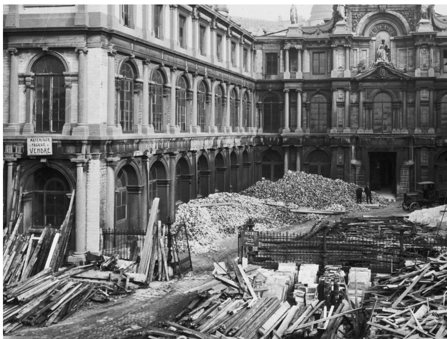
FIG. 4.5 : Démolition de l'ancien Palais Granvelle, 1928
