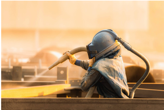
(a) Sablage d'une structure métallique
