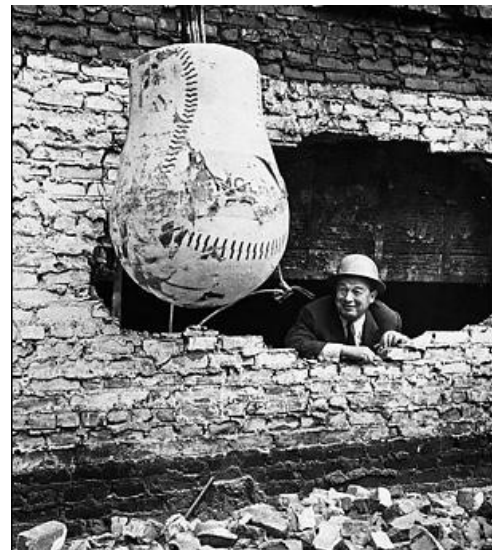
(d) Boule de démolition
