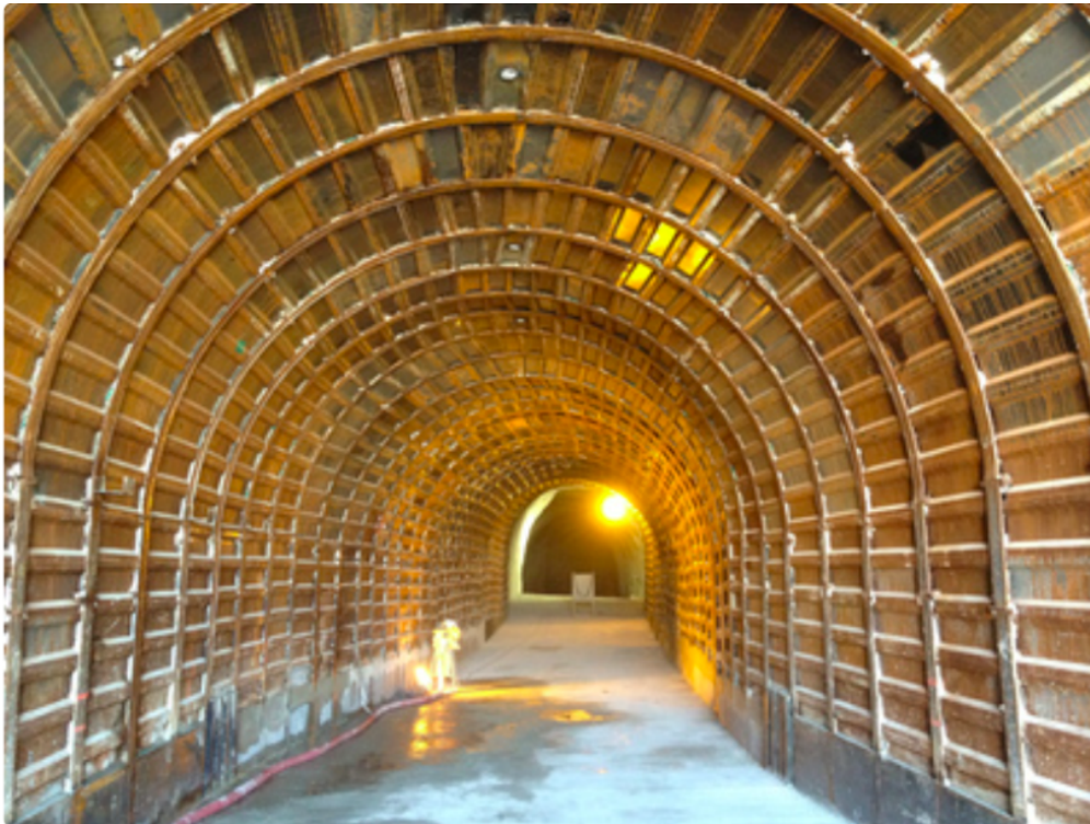
FIGURE I.8 – Soutènement par blindage
