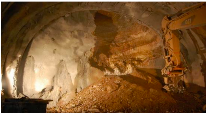
FIGURE I.2 – Creusement à pleine section
