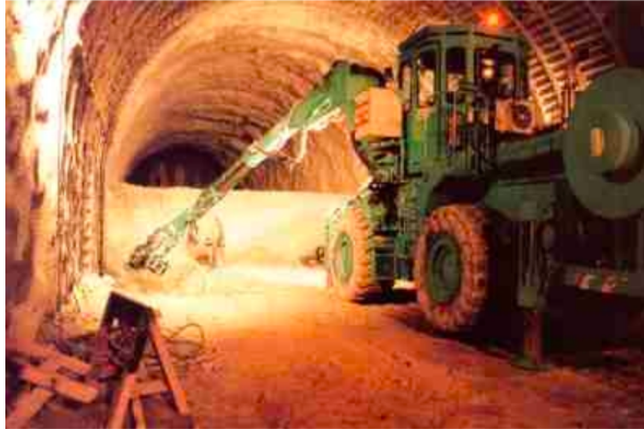
FIGURE I.3 – Creusement en demi-section
