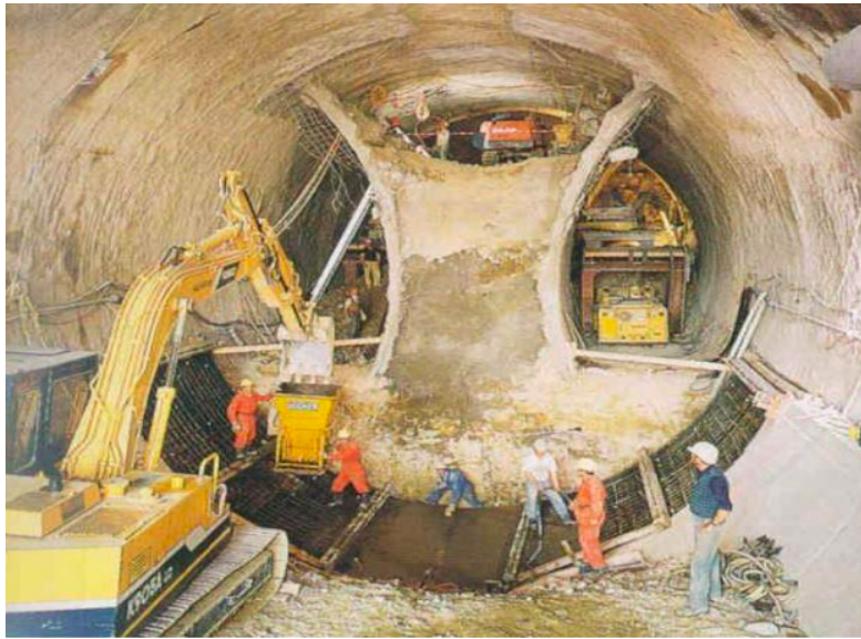
FIGURE I.4 – Creusement en section divisée
