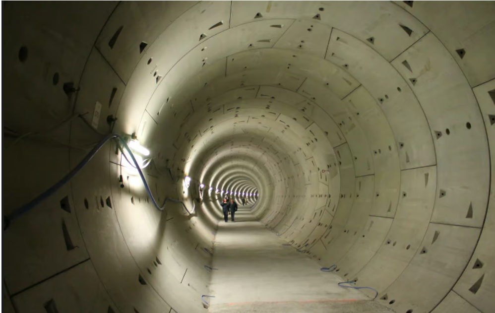
FIGURE I.9 – Voussoirs Préfabriqués
