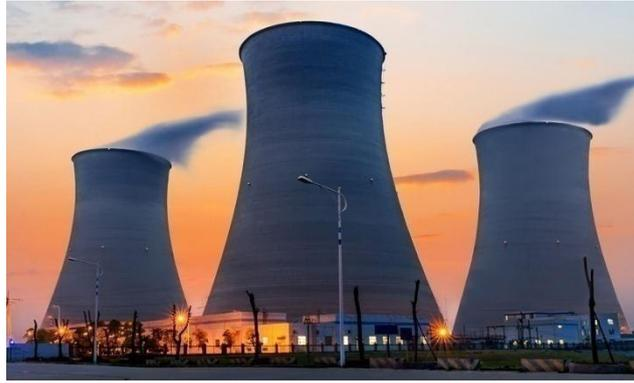
Figure 1.1 : Tours de refroidissement à structure hyperbolique en béton
