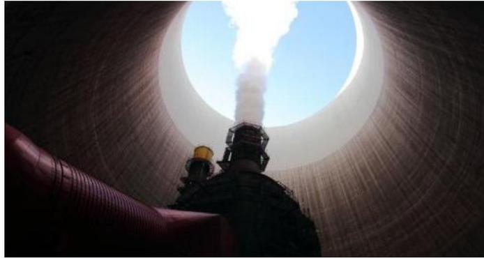
Figure 1.12 : Système d'injection des gaz de cheminée dans une TRSTN
