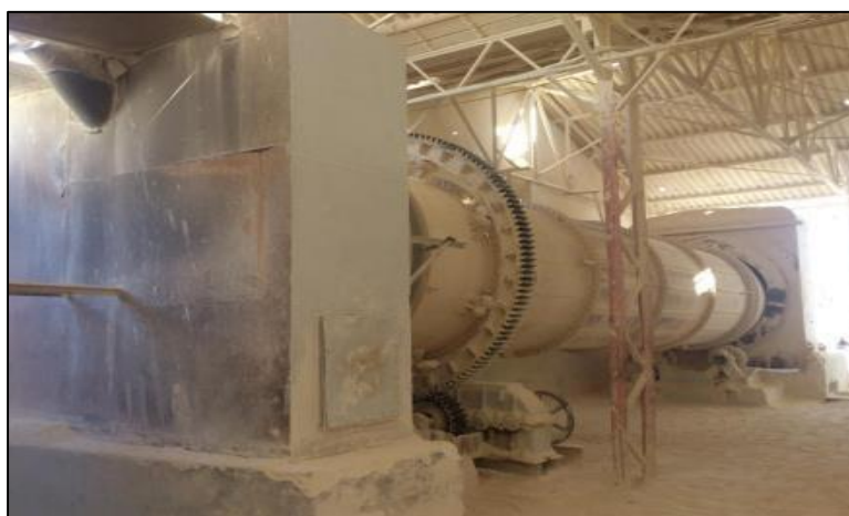
Figure 11 Opération de séchage
