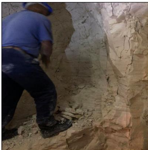
Figure 9 Opération d'abattage manuel
