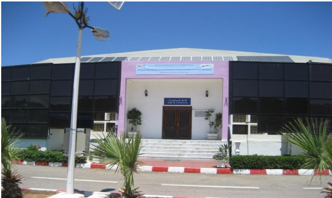
Fig. 1. 14 : Centrale photovoltaïque de 12.5 KWc réalisée à l'UDES
