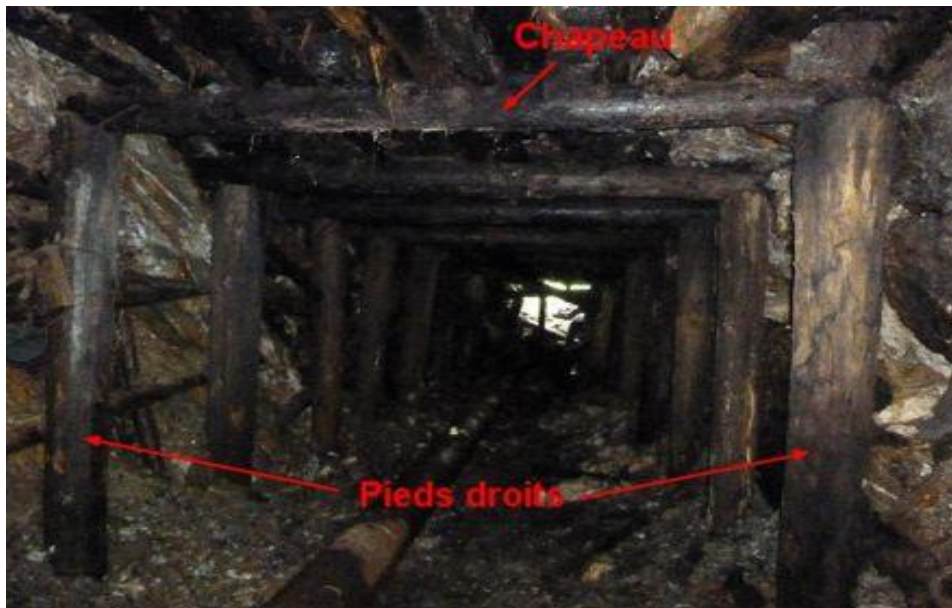
Figure 4.3: Soutènement par boisage dans la mine d'Ichemoul [12].
