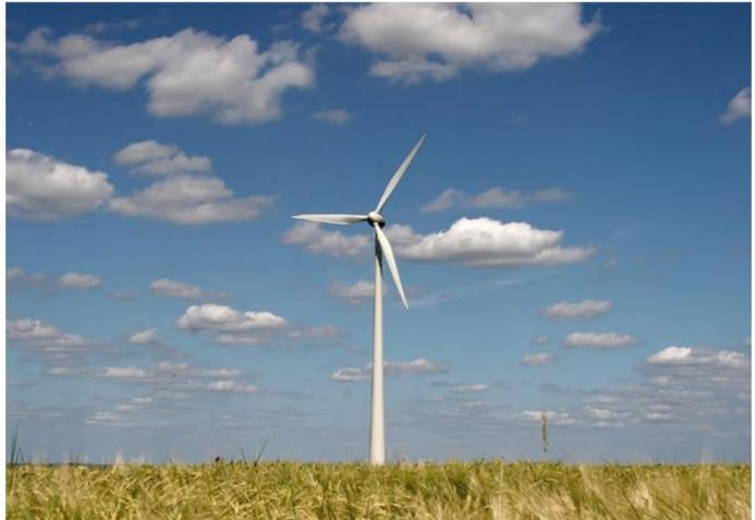
Figure 1.7 : Eolienne à axe horizontale
