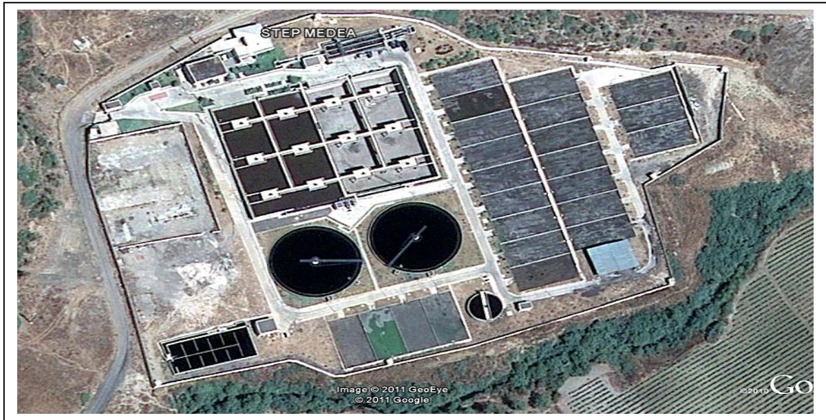
Figure III.1 : Station d'épuration de la ville de Médéa
