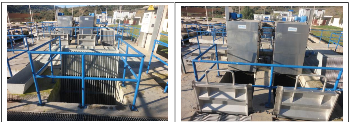
Figure III.2 : Grille grossière et fine (mécanisée et manuelle) de la STEP de Médéa
