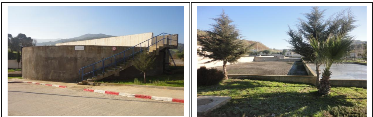
Figure III.7 : Epaississeur des boues et lits de séchage de la STEP de Médéa
