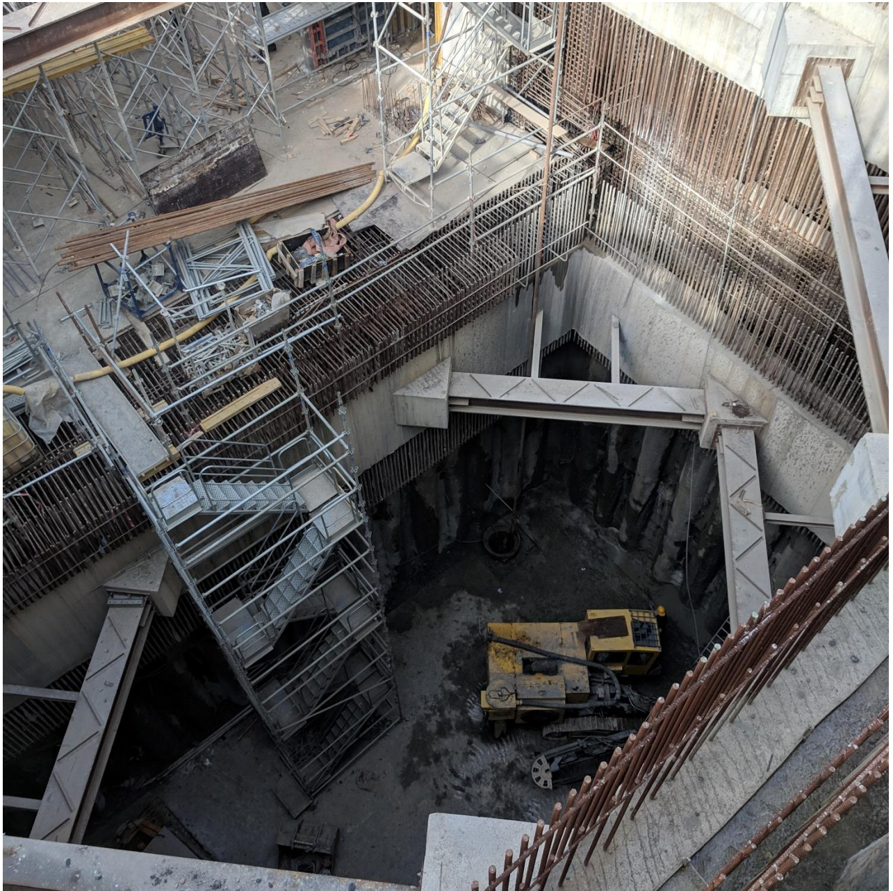
Figure 2.14- Pieux avec des buttons (photos prise dans PV05).
