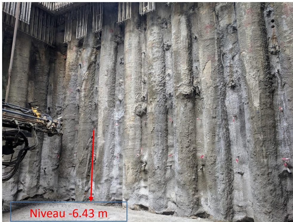
Figure 6.9- Le Front de taille avant l'excavation
