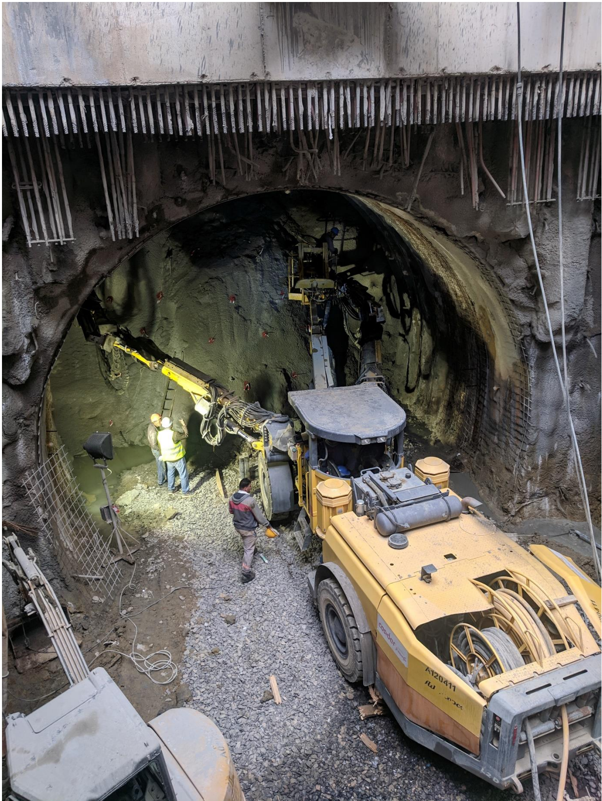
Figure 6.18 - Vue oblique du JUMBO COPCO A120411 en opération au niveau du puits de ventilation #5
