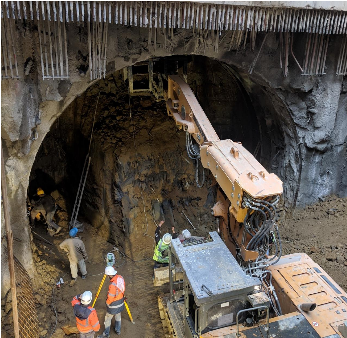
Figure 1.5 - Creusement de rameau de connection # PV5 en pleine section
