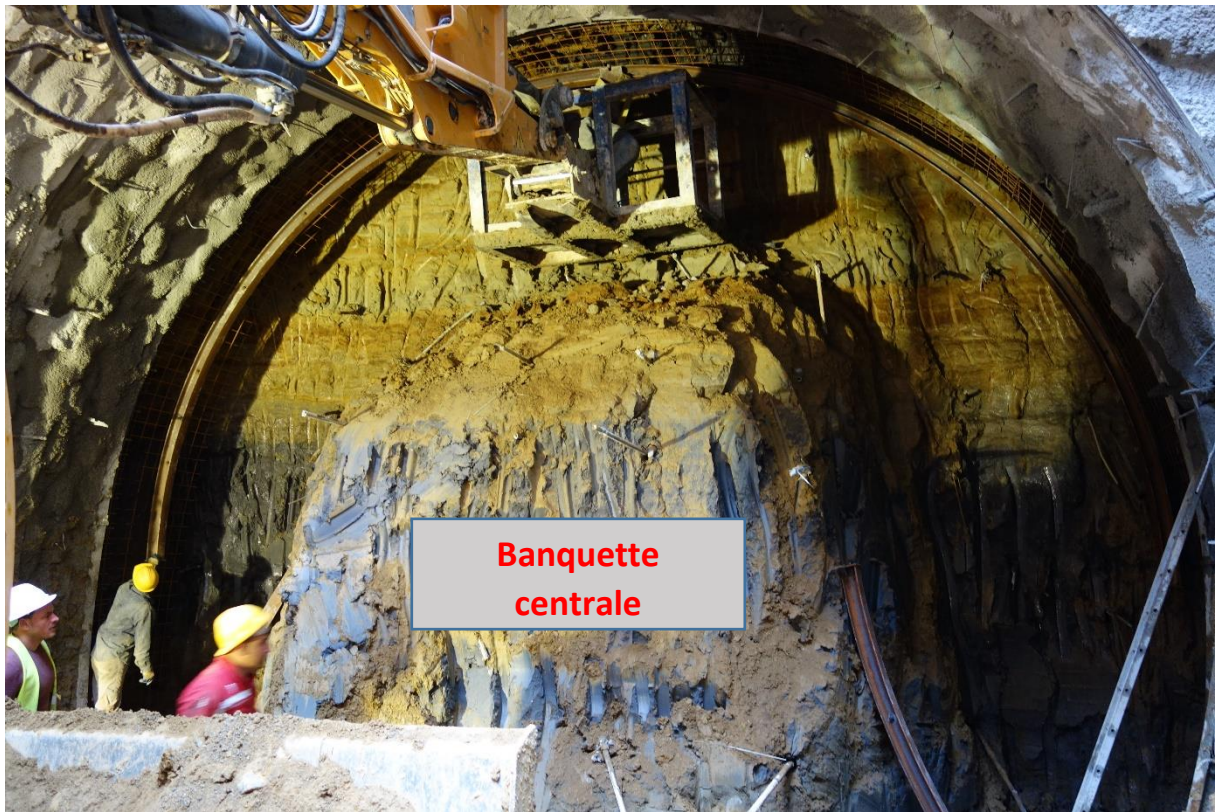
Figure 6.20- Banquette centrale pour garantir la stabilité du front
