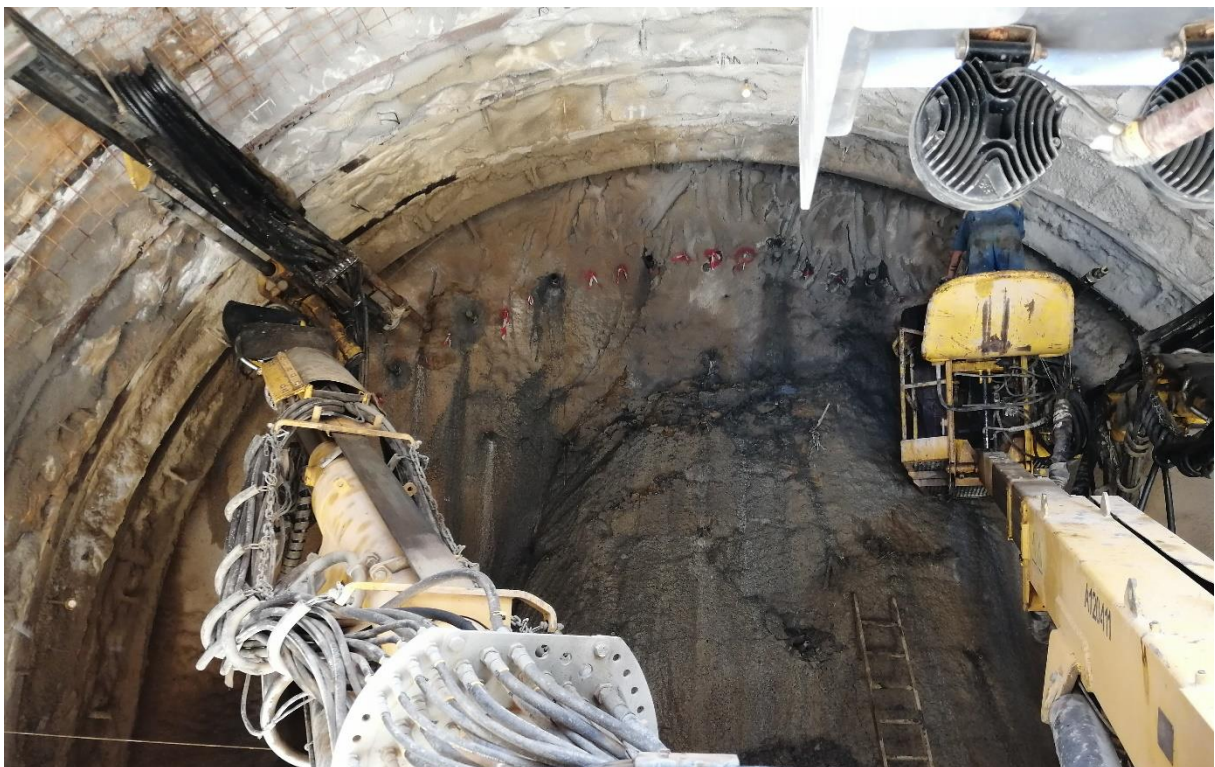
Figure b-6.17- opération de forage afin d'injecter les tubes métalliques de la voute parapluie
