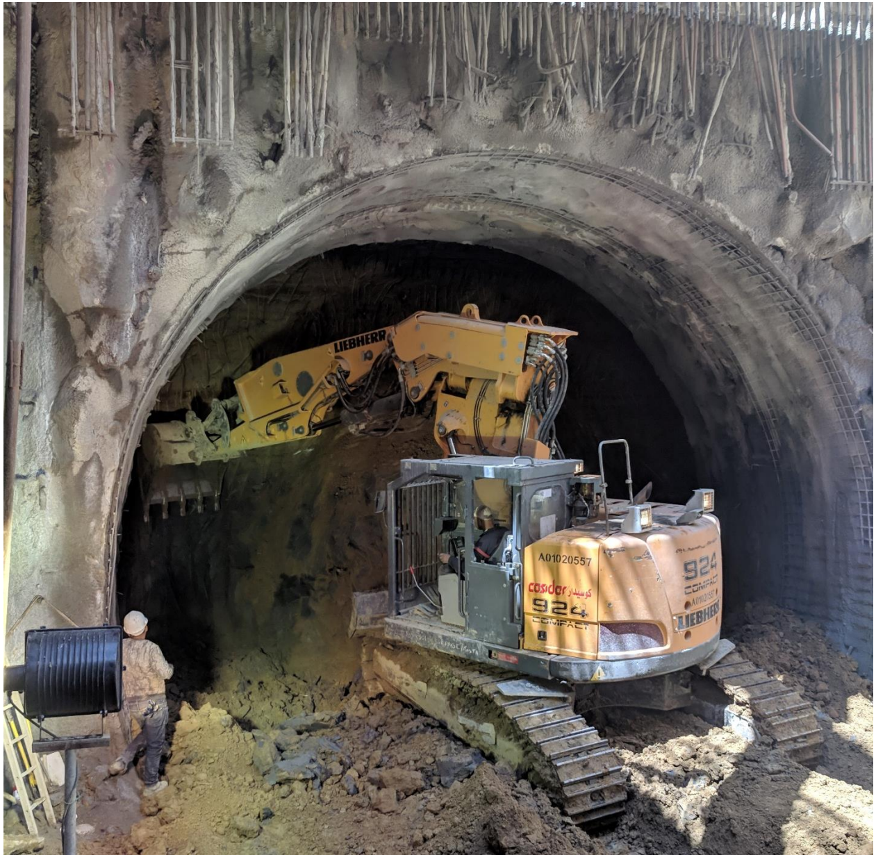
Figure 6.19- Excavation de la section totale du rameau de connexion au niveau du PV#5
