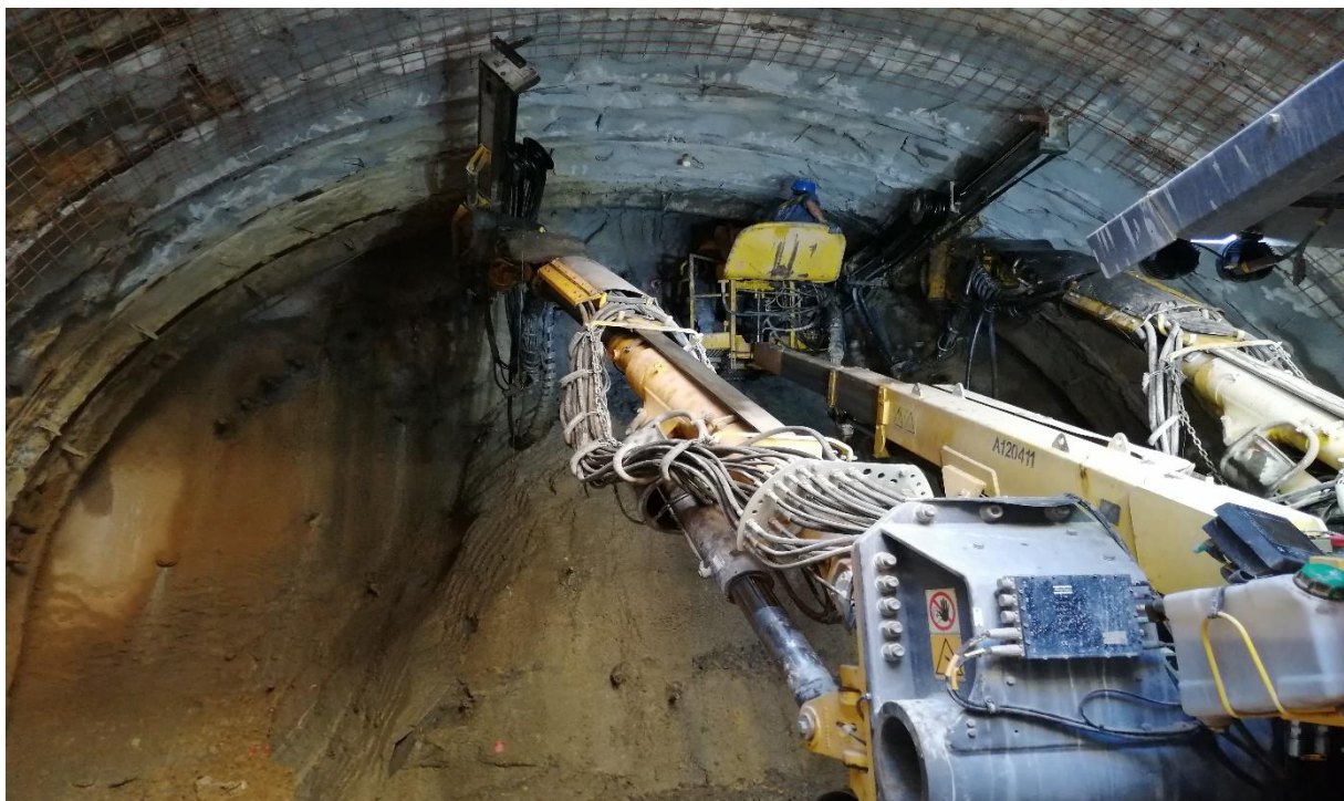
Figure 2.2- Installation de la voûte parapluie au niveau du rameau de PV5 #
