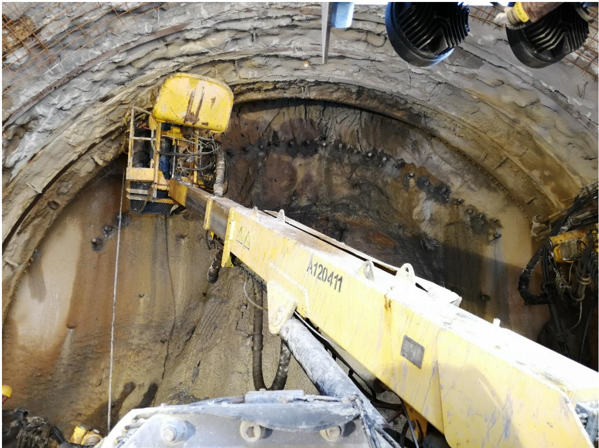
Figure a-6.17- opération de forage afin d'injecter les tubes métalliques de la voute parapluie
