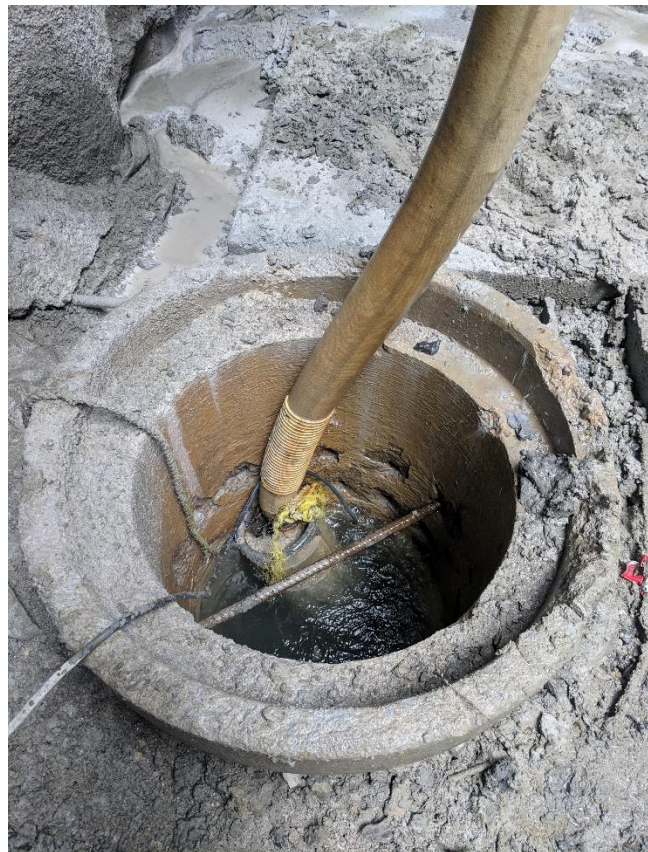
Figure 6.28- forage de pompage d'eau au niveau de PV#05
