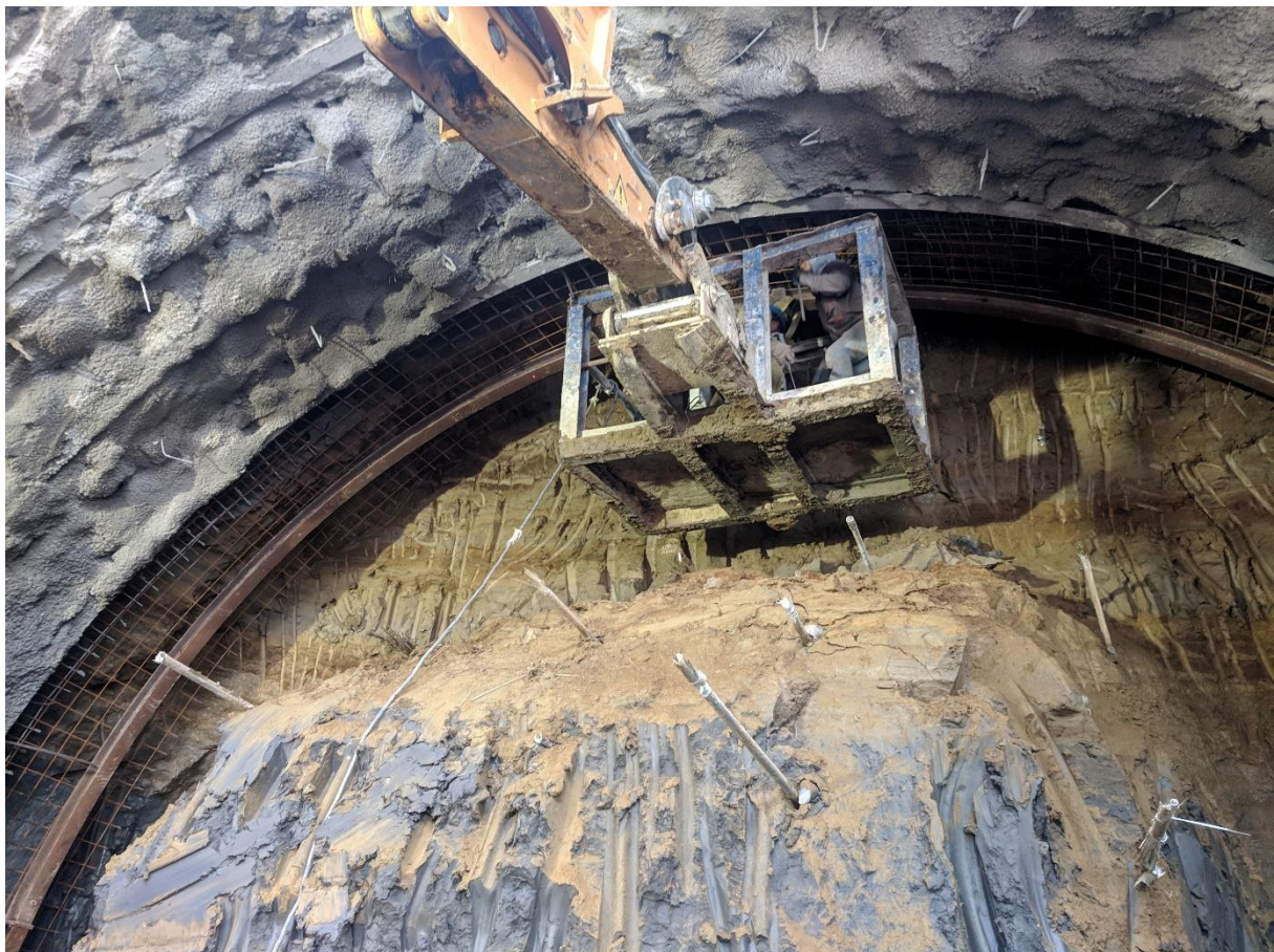
Figure 6.21- Exemple de la mise en place du cintre HEB 120
