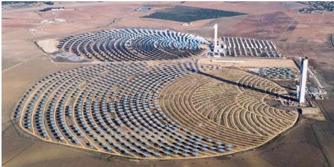
Figure 1.12 : Centrale solaire à tour
