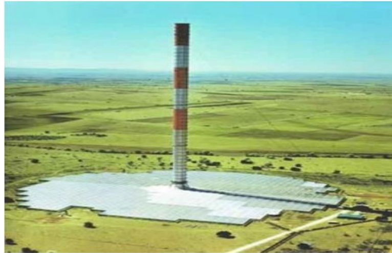
Figure 3.1 : Centrale à effet de cheminée de Mansanares.
