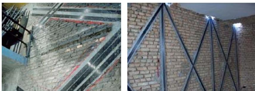
Figure II.20 Réhabilitation d'un mur en maçonnerie [64].
