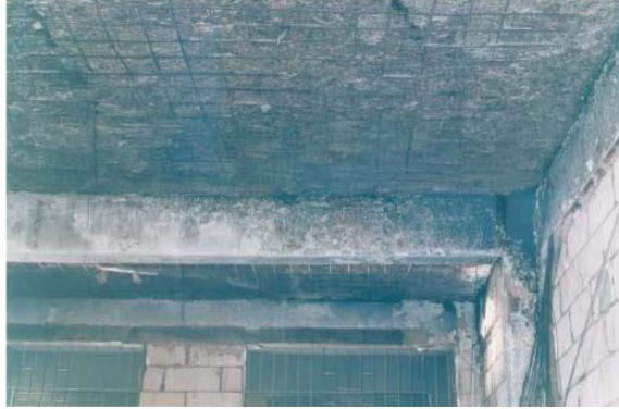
**Figure I.3** Dégradation de la structure du supermarché d'Annaba (Eclatement de l'enrobage de la poutre et du plancher) [67].
