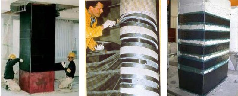
**Figure II.21** Types de disposition des renforts sur un poteau [33].
