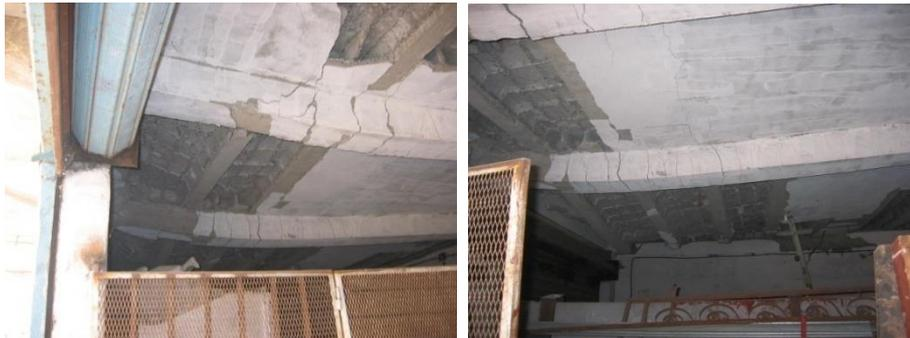
**Figure I.4** Fissurations excessives de deux poutres d'un plancher due à la chute des panneaux en maçonnerie de l'étage au dessus [30].
