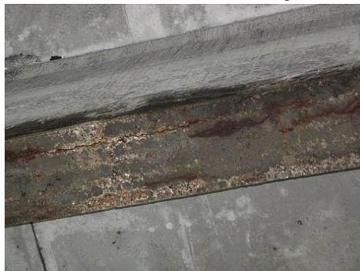
Figure I.2 Fissuration d'une poutre en béton exposée aux eaux de mer [6].
