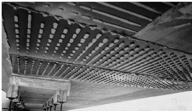
**Figure II.9** Renforcement du viaduc de Terrenoire par tôles collées perforées -Brevet Freyssinet- [65].
