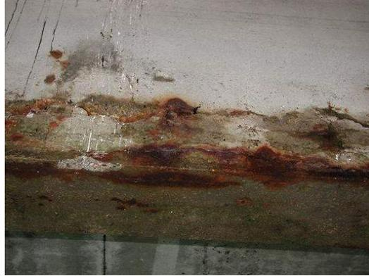
**Figure I.1** Poutre située en bord de mer sous l'effet de l'agression des chlorures [6].
