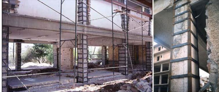
Figure II.5 Chemisage en acier appliqué aux poteaux [6].
