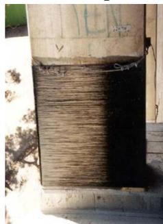
**Figure II.22** Renforcement d'une colonne par ma méthode *Stratification au contact* [33].
