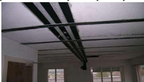
Figure II.19 Renforcement d'une dalle en béton armé [52]
