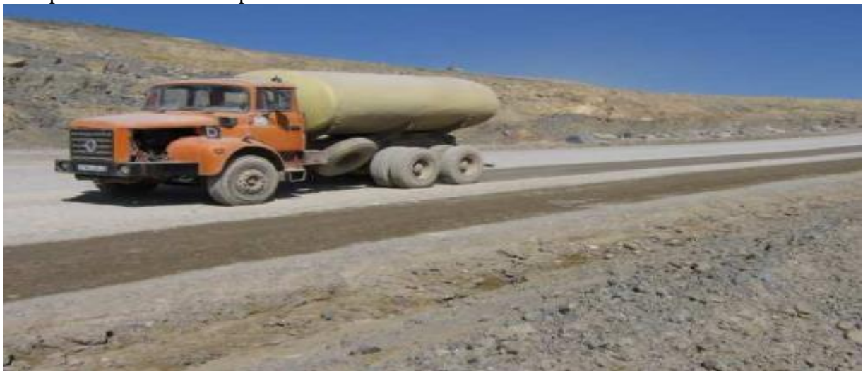
Figure VII. 1: Arrosage des pistes (photo au niveau du carrier de Chouf Ammar)
