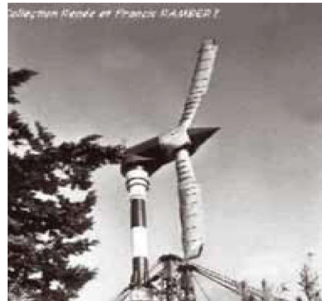
Figure 1-14: Eolienne de 100 kW de Grand Vent [10]
