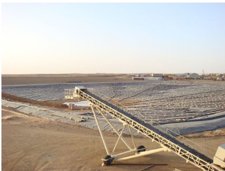
FIGURE 2.9 – L'air de lixiviation ( Leach Pad ) mine d'Amesmassa
