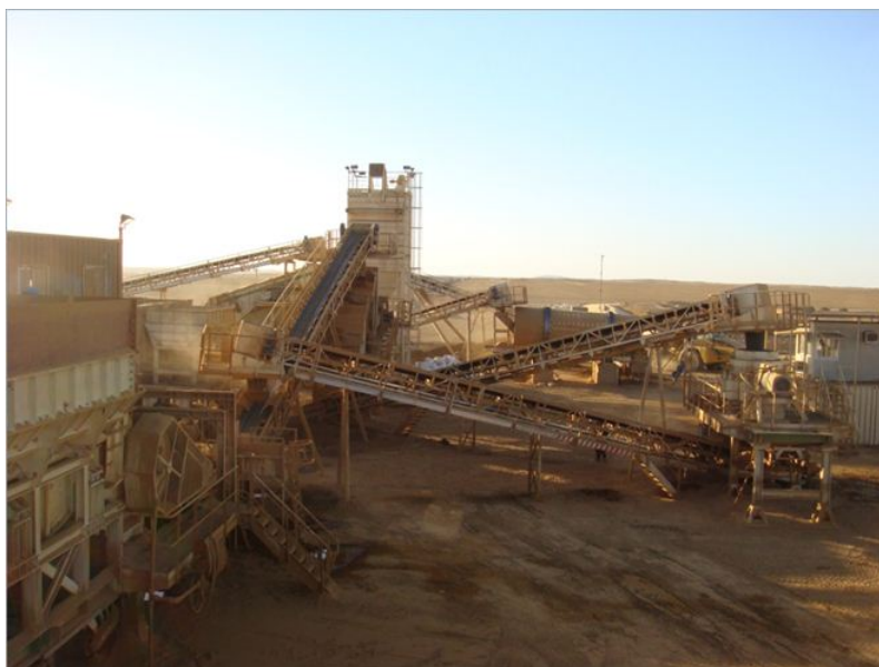
FIGURE 2.6 – Préparation mécanique site d'Amesmassa
