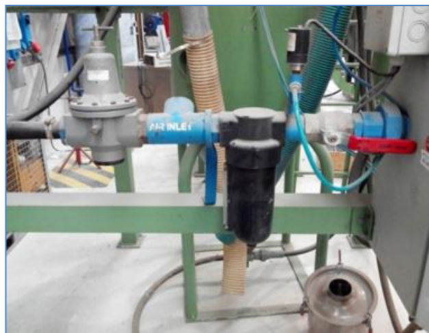
Figure II.4: Filtre à air
