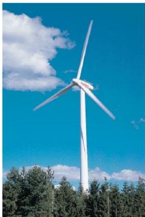
Nordex tripale 1,5 MW
