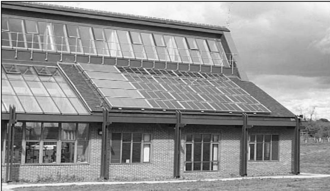
Figure II.6 : Capteurs solaires combinés intégrés à la toiture de Brockshill Environment Center.
