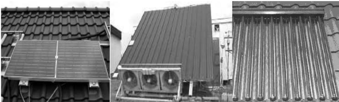
Figure I.8 : De gauche à droite : Capteurs solaires plans vitrés [8], non vitrés [9] et capteurs solaires à tube sous-vide.
