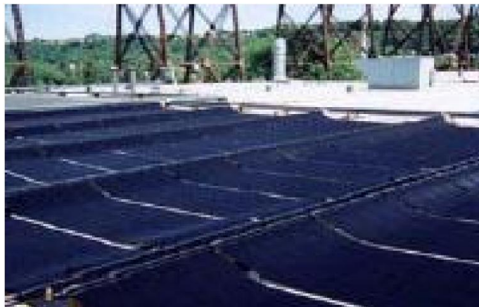
Figure I.9 : Capteurs solaires non vitrés à revêtement sélectif [10].
