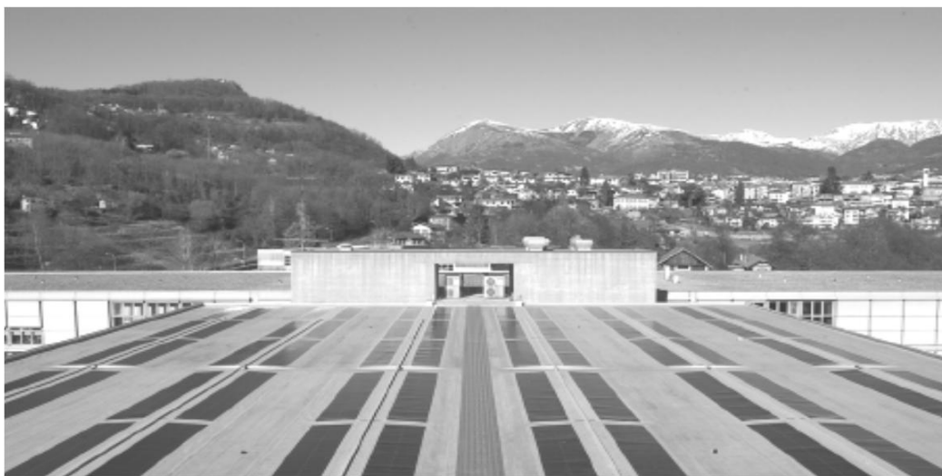
Figure I.6 : Intégration de 900 m 2 de modules PV Sarnasol sur la toiture (inclinée à 20°) d'une école à Lugano en Suisse (12 branches de 5 modules PV Sarnasol) [6].
