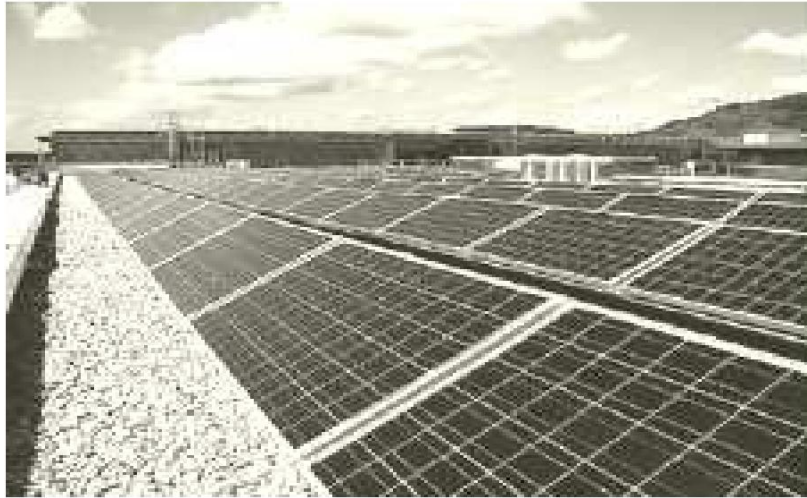
Figure I.3 : Panneaux PV non intégrés au bâti.
