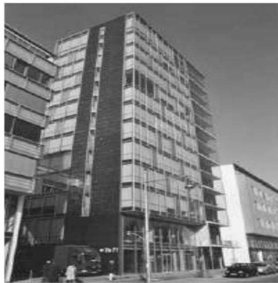
Gare de Freiburg – Allemagne
