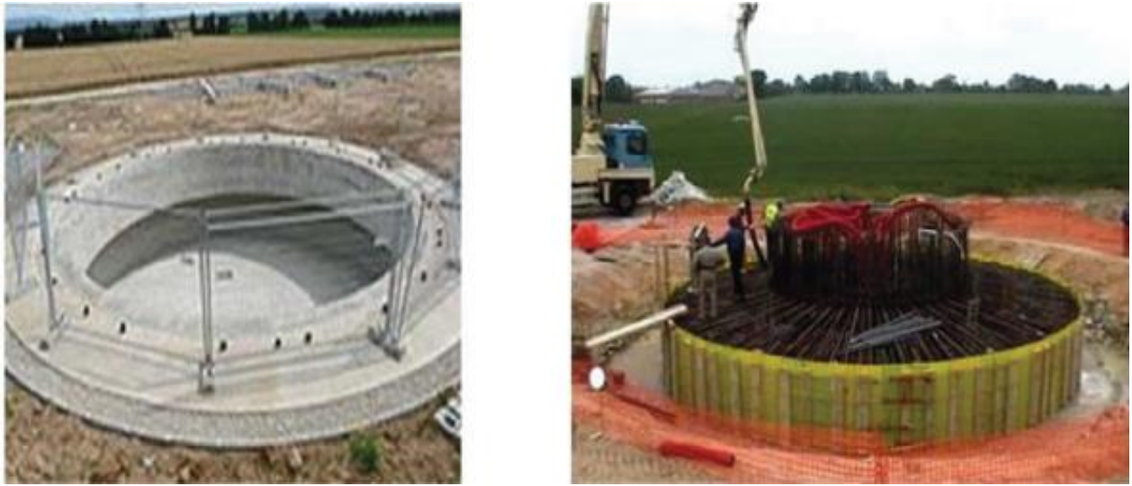
Figure 1.10 : Les fondations de grandes éoliennes [1].
