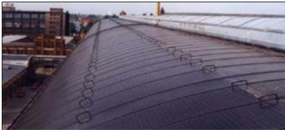
Figure II.1: Toiture constituée d'un absorbeur sélectif en acier inoxydable
