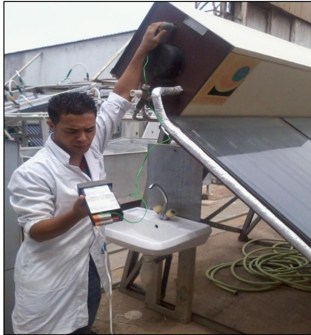
Figure V.14: Mesure de la température a la sortie du ballon de stockage/puisage
