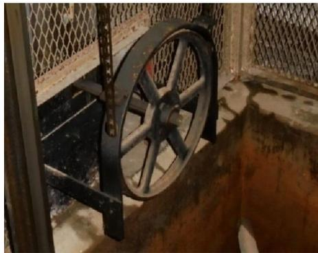
*Figure II.16 : Poulie inférieure d'iso-nivelage*
