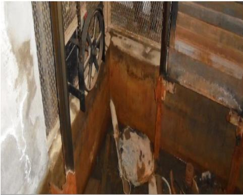
Figure II.29 : Etat des rails au niveau de la cuvette
