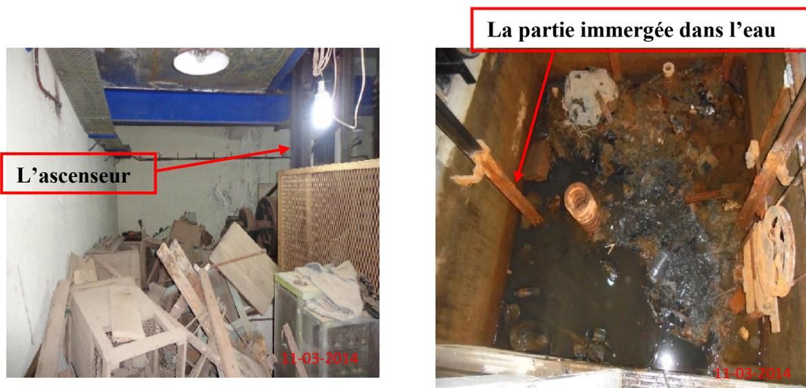
Figure II.1 : Débris aux alentours de l'ascenseur      Figure II.2 : Eaux usées dans la cuvette de l'ascenseur
