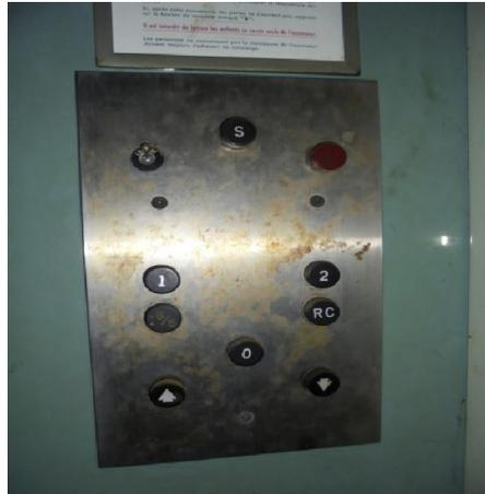
*Figure II.6 : Le tableau des boutons de commande*
