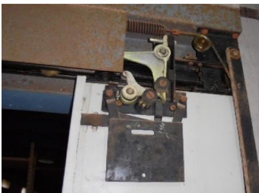
Figure II.31 Fin de course de fermeture des portes
