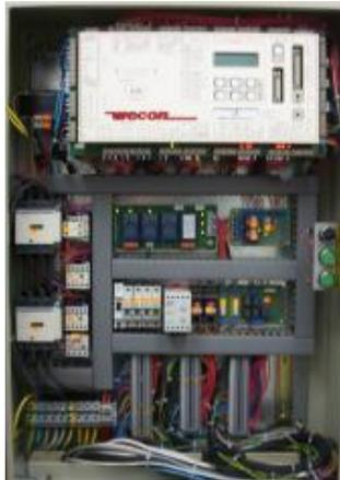
Figure III.2 : Armoire de commande de type VVVF
