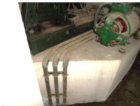
*Figure II.38 : Protection d'un câble électrique*
