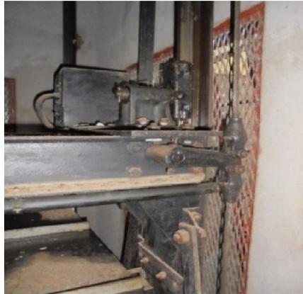
*Figure II.34 : système parachute*
