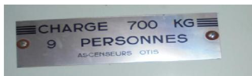
Figure II.5 : La plaque signalétique de la charge maximale
