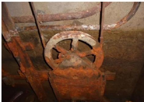
*Figure II.15 : Poulie tendeuse du câble du système de sécurité*
