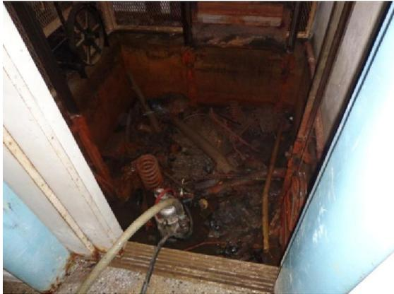
Figure II.3 : Vidange des eaux de la cuvette
