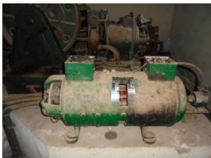
Figure : II.25 Redresseur de courant
