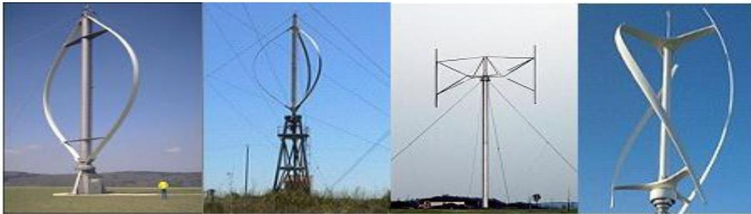
FIGURE 1.14 – Différentes déclinaisons des éoliennes de type Darrieus [9]
