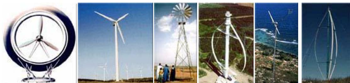
**Figure I.9:Types des éoliennes.**
