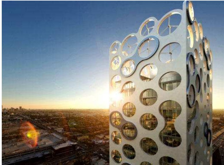
FIGURE I.9 – Le projet du Cor building à Miami
