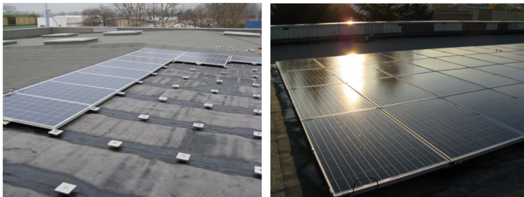
FIGURE I.5 – exemples de système photovoltaïque sur toit terrasse
