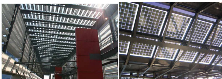
FIGURE I.6 – exemples de verrières photovoltaïques
