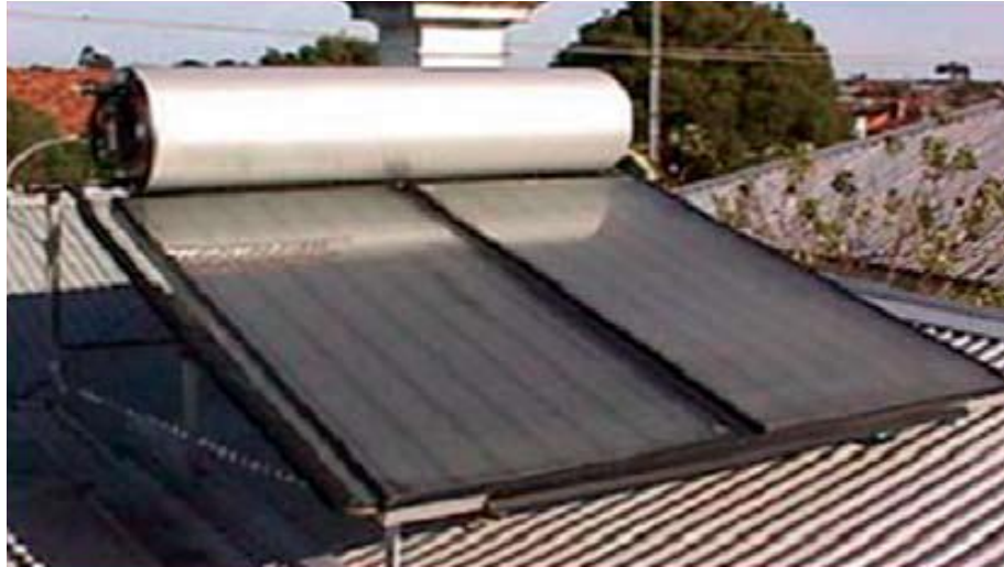
Figure I.7: Système de production d'eau chaude domestique (Thermosiphon)
