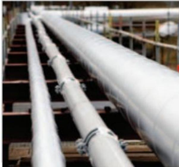
**Figure I.7 :** Tuyauterie isolée
