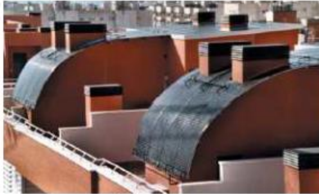
Fig (1.8) Installation de production d'eau chaude sanitaire [10]
