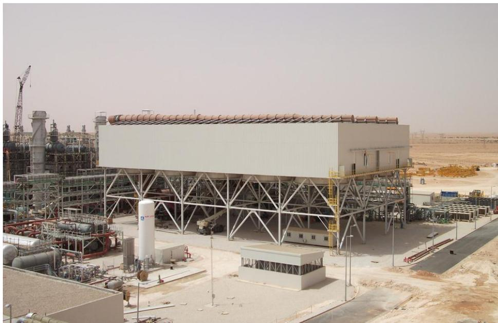
Figure 38 : L'aérocondenseur SPX de la centrale [6]
