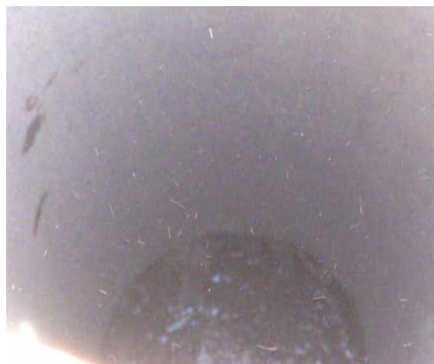
Figure 18 : Photo de l'intérieur du puits.
