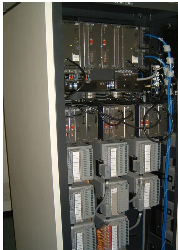
Figure II. 4. Vue générale de la FCS
