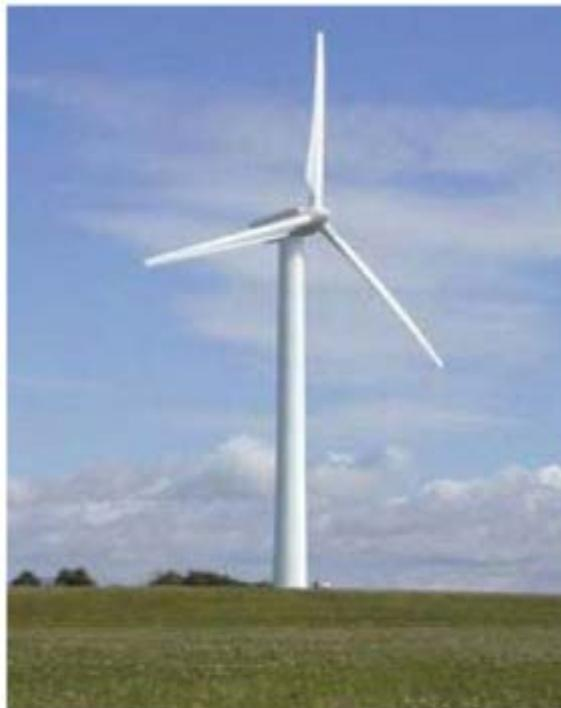
Fig.2.5. Aérogénérateur à axe horizontal.
