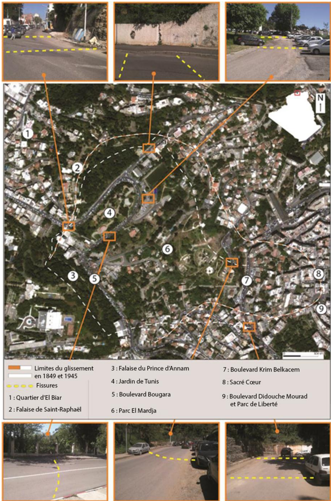
Figure 3-3 : Image satellite montrant l'emplacement du glissement d'El Biar et photographies récentes (prises le 08/05/2012) montrant des fissures et des affaissements dans les routes.
