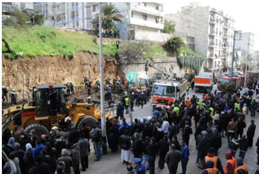
Photo 3-2 : Effondrement d'un mur de soutènement sur la route Bougara.
