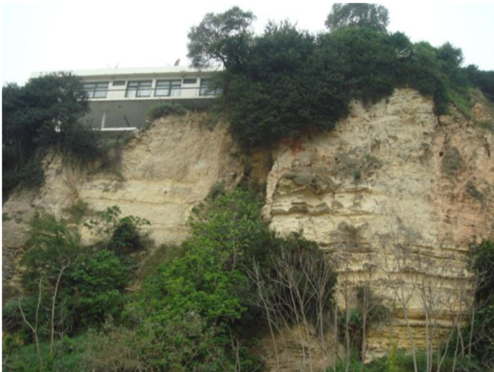
Photo 8-4 : Maisons en danger sur le Balcon de Saint-Raphaël.
