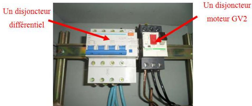
**Figure II.10 :** Disjoncteurs installés dans le boîtier mural qui alimente le banc d'essai
