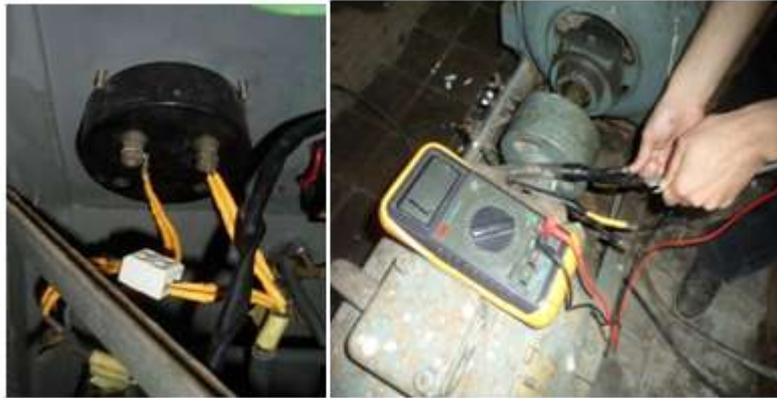
**Figure II.8 :** Contrôle de la continuité des circuits et rénovation de l'isolation des fils électriques
