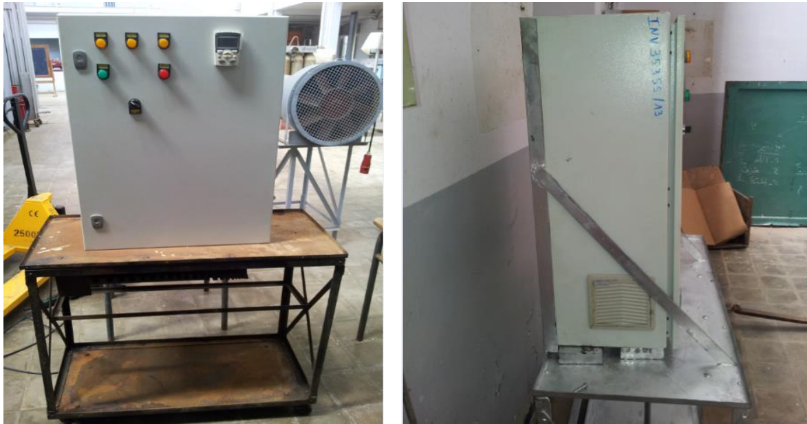
Figure V.15 : Le nouveau support du variateur de vitesse.
