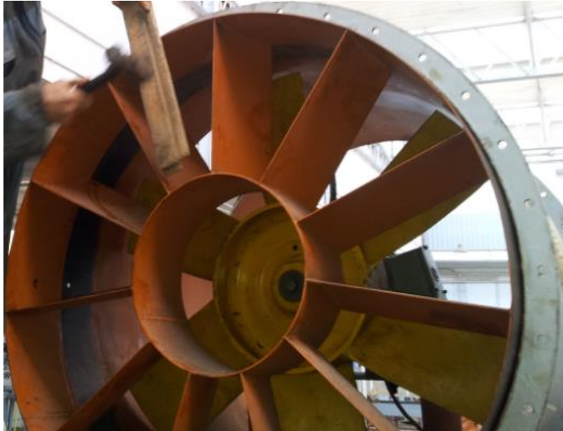
Figure V.12 : Montage du redresseur.
