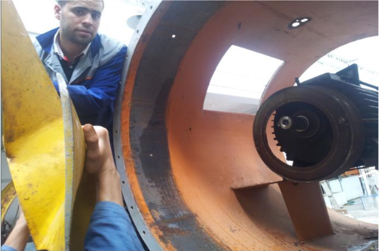
Figure IV.12 : démontage du ventilateur.
