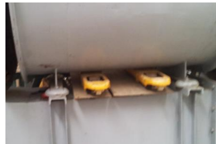
Figure.IV.6:l'ajustement des deux niveaux par une tôle et des cales
