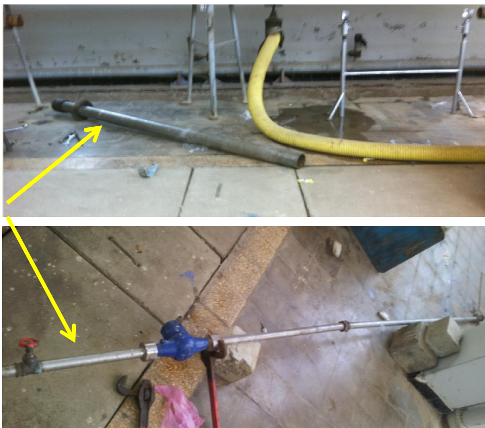
Figure II-6 : Démontage des différents tronçons constituant les conduites
