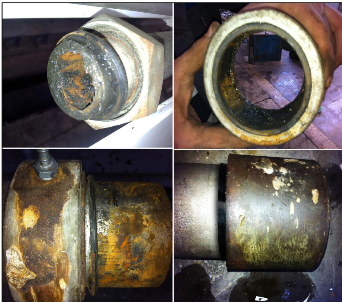
Figure II-7 : L'état des conduites au cours de leur démontage
