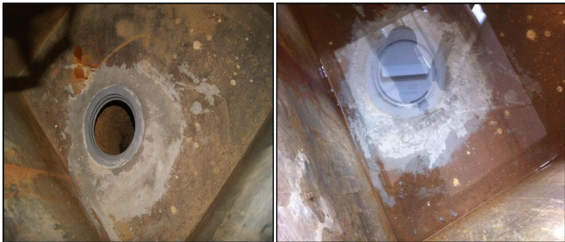
Figure III.6 : Modifications apportées au bassin de déversement
