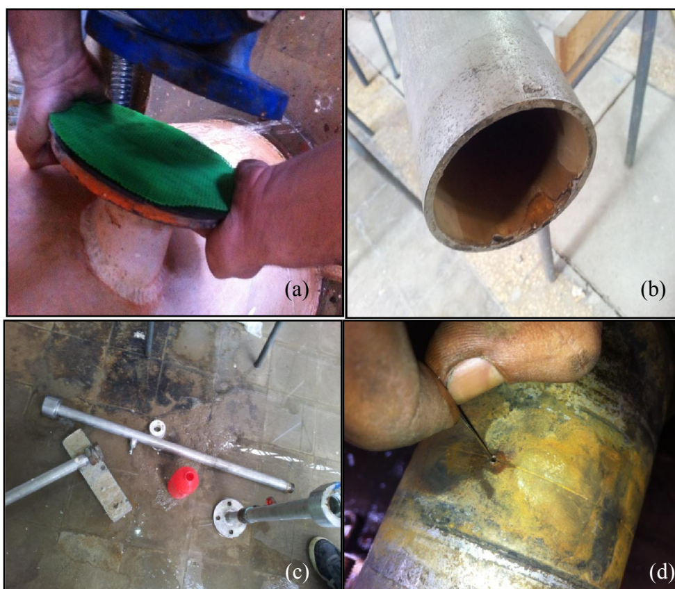
Figure II-8 : Les différentes opérations effectuées pour remédier à l'état des conduites
