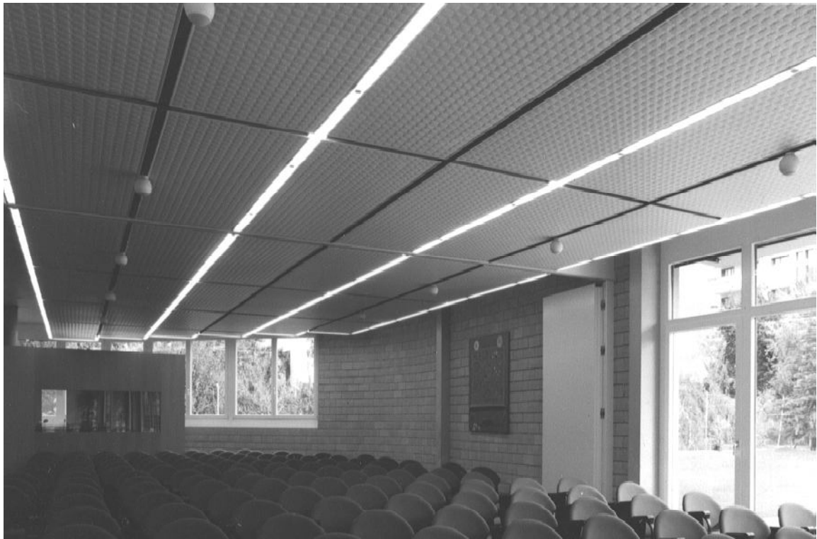
Figure 4.8: Plafond climatique dans une salle de conférence.
