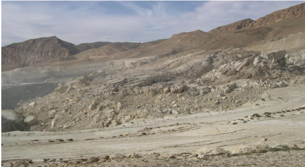
Figure 1.III: Photo montrant le glissement de 2007 dans la carrière de phosphate de KEF ESSNOUN
