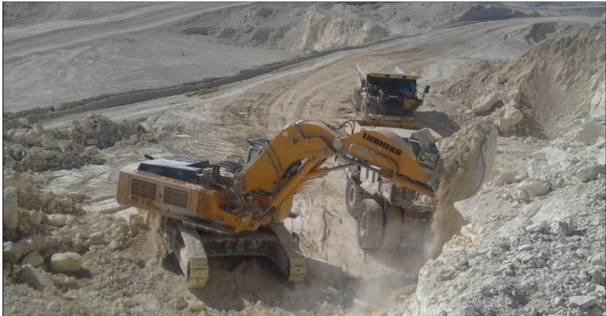
Figure 4.VI: Opération de chargement dans la carrière de Kef Essnoun
