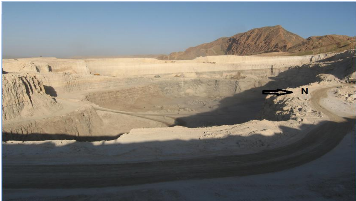
Figure 2.III: Photo montant la fosse de la carrière de KEF ESSNOUN avant le glissement de 2007
