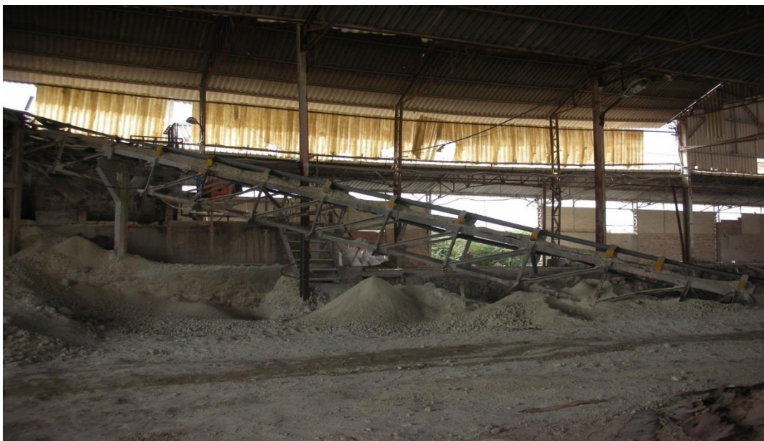
Un convoyeur à bande permettant le transfert de la bentonite vers le séchoir
