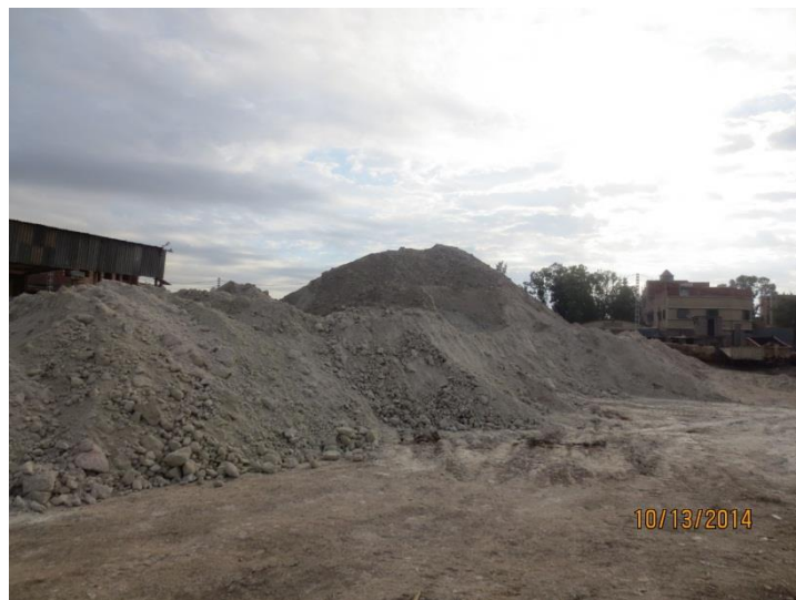
Figure .II. 9: Stock tout venant bentonite u niveau de l'unité de production.
