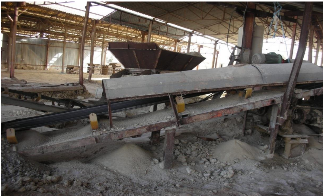
Transporteur à bande permettant le transfert de l'argile concassé vers le malaxeur
