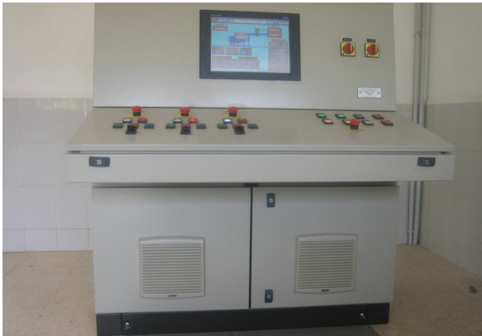
Figure III.2 Vue de face avant de la HMI [1]
