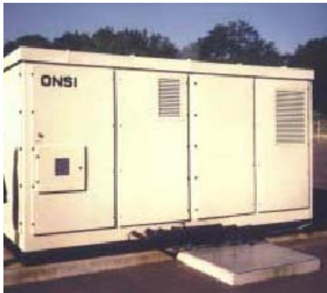
Figure 1.1 : PAFC de 200 kW<sub>e</sub> [1]
