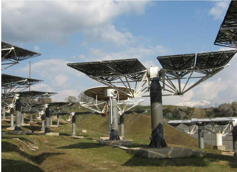
**Fig2.3** Système de poursuite de l'héliostat [26]
