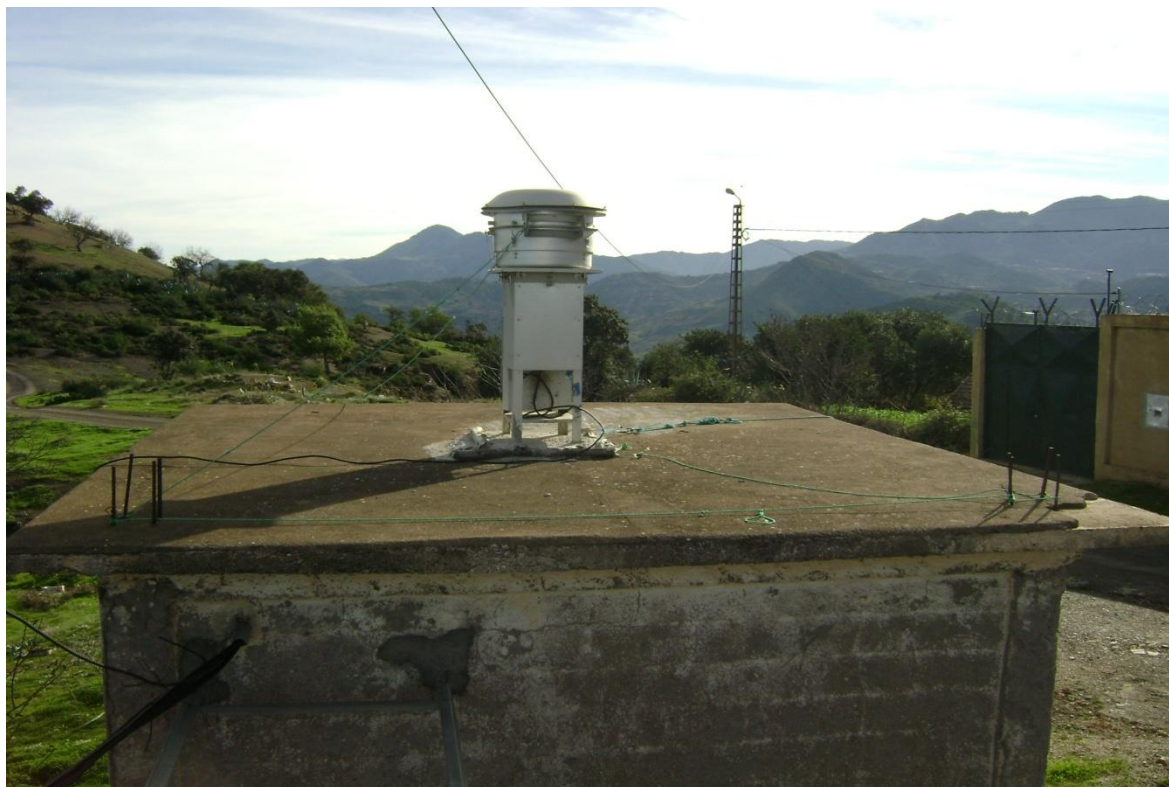
Figure N° 20 : Poste de prélèvement à Larhat, Tipaza.
