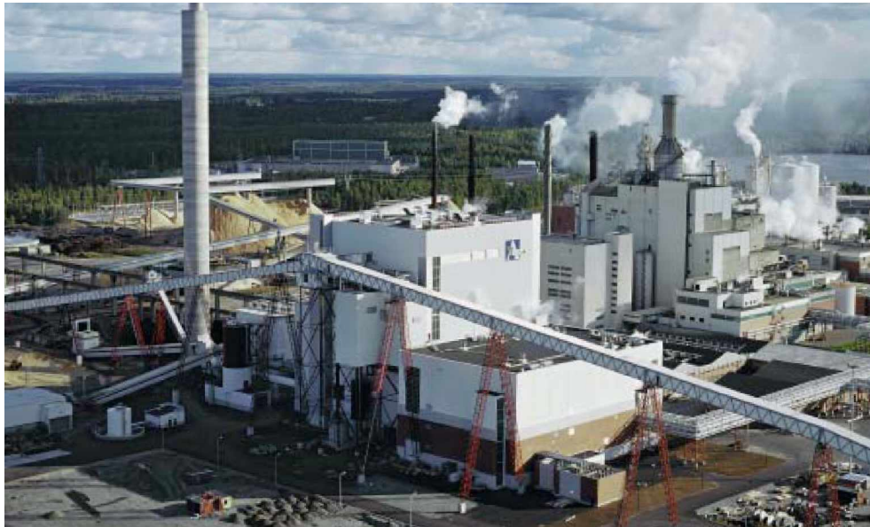
Figure I.6 : Centrale turbine à vapeur de 240 MW à cogénération (Alholmens Kraft Finlande), qui produit environ 100 MW pour le processus de l'usine de papier -UPMKymmene PIETARSAARI- et environ 60 MW pour le chauffage urbain de la ville de -Pietarsaari-. [8]
