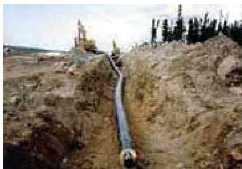
Figure VI.6 : enfouissement d'une conduite
