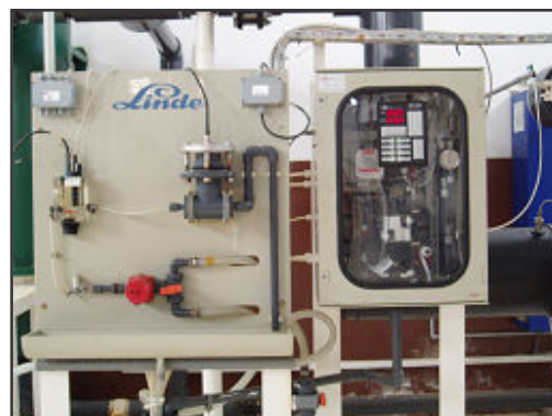
A gauche : PH mètre, conductimètre, Chlore mètre. A droite, table de l'indice de colmatage
