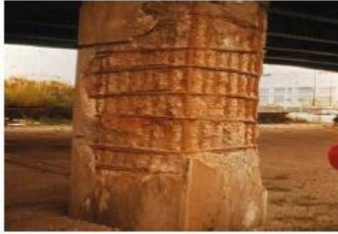
**Figure 3.7: Dégradation d'un pilonne d'un pont en contact avec sol riche en sulfate**
