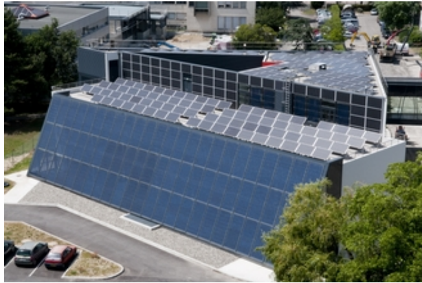
FIGURE 1.7: Façade et toit photovoltaïque du bâtiment Adream
