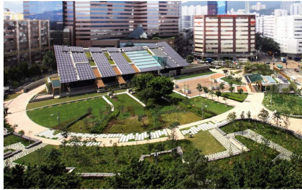
FIGURE 1.4: Extérieur du bâtiment Mansion ZBC.
