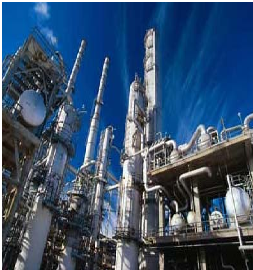
Figure 2.1 : Vue partielle du GP1Z.
