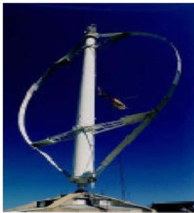
Darrieus (Québec) Haut : 110 m, 4 MW
