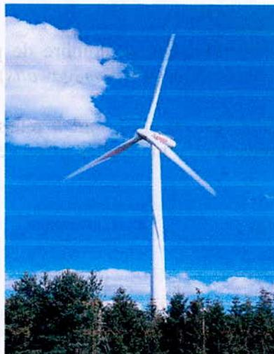
*figure II.3 : une éolienne à axe horizontal*
