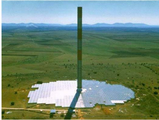
Figure 1.1 : Prototype de cheminée solaire installée à Manzanares – Espagne [45]
