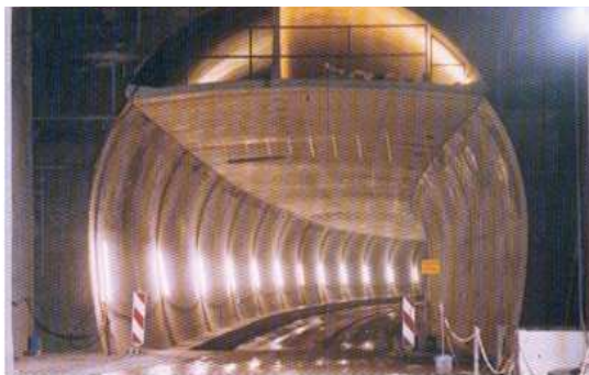
Fig. 2.7 Vue en coupe d'un tunnel ventilé transversalement.
