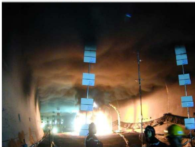
Fig. 1.4 Propagation de fumées dans un tunnel routier [2].
